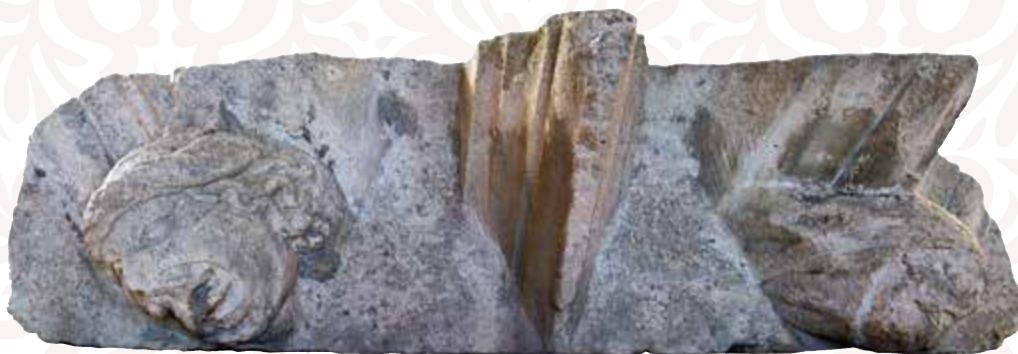
Culots à nervures et visages provenant d'une voûte d'une salle du donjon (XIII e siècle)
